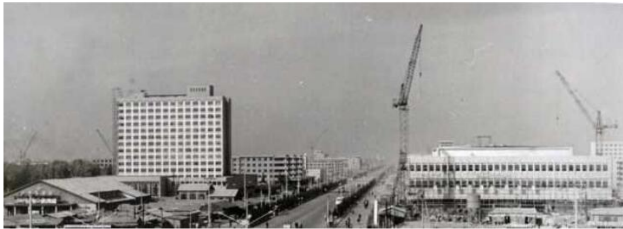
图三唐百集团条式楼（副楼）建设场景
