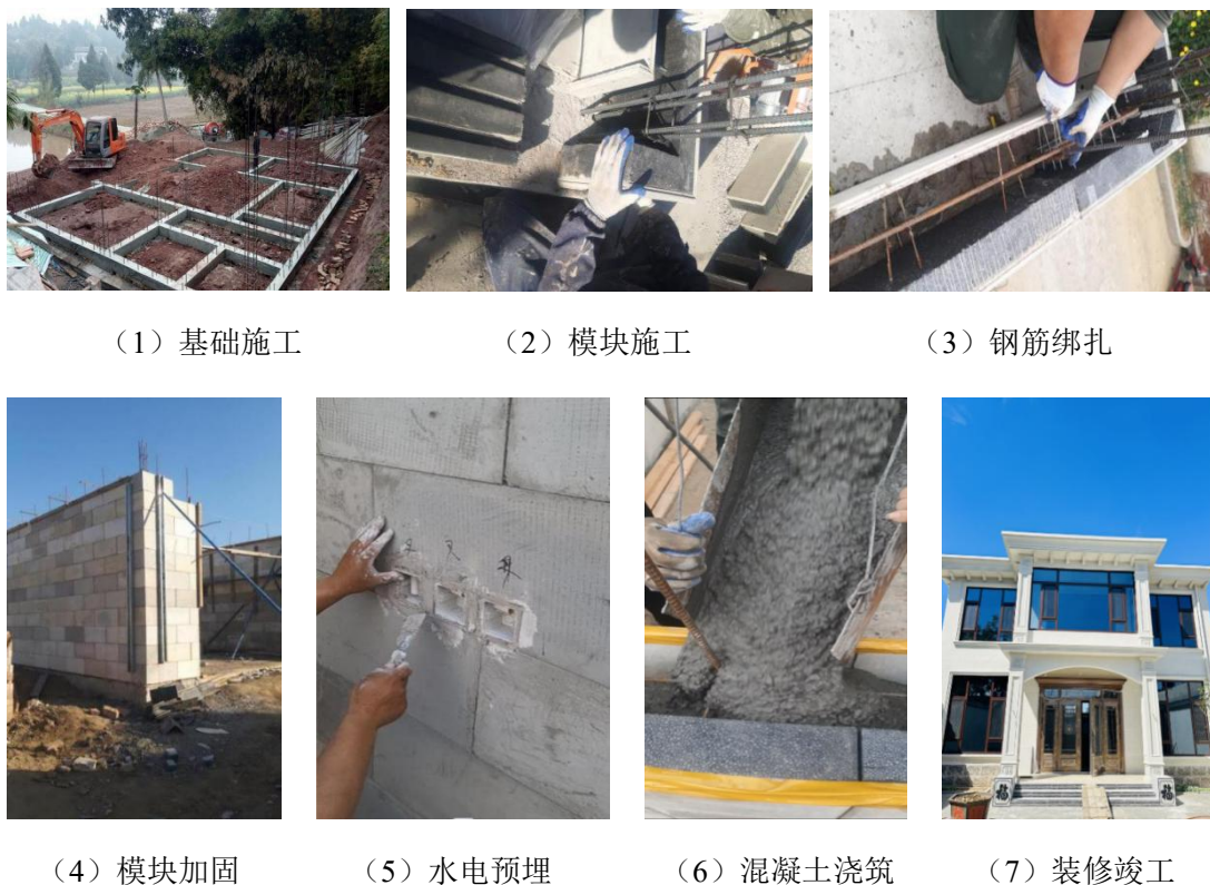
图 2 I 型拼装模块施工流程图
