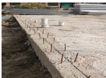
(2) 基础预留钢筋
