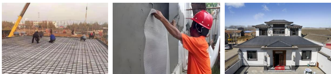
(7) 绑扎楼面钢筋及混凝土浇筑 (8) 内外墙抹面 (9) 装修竣工
