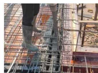
(8) 混凝土浇筑
